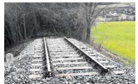
Der Bahndamm wurde vom Baumbewuchs befreit, eine neue Schotterung aufgetragen und ein Schienenrost errichtet.
